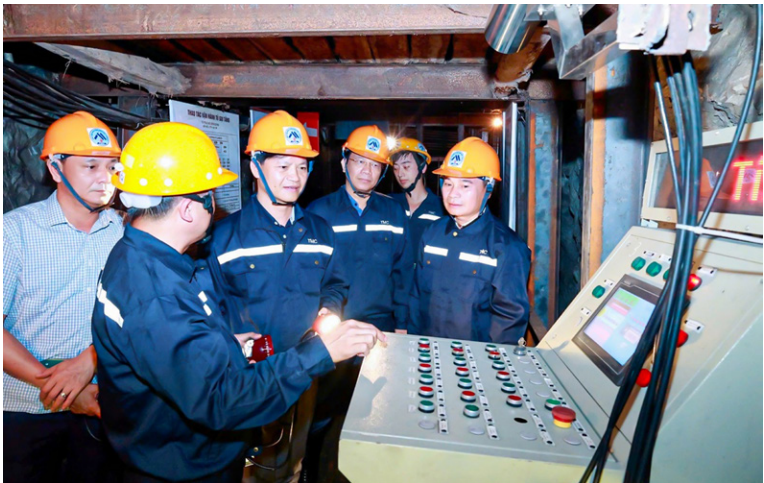
Đoàn công tác kiểm tra thực tế điều kiện sản xuất, hệ thống điều khiển, vận hành thiết bị phục vụ hoạt động khai thác khoáng sản tại Phân xưởng khai thác Làng Hích
