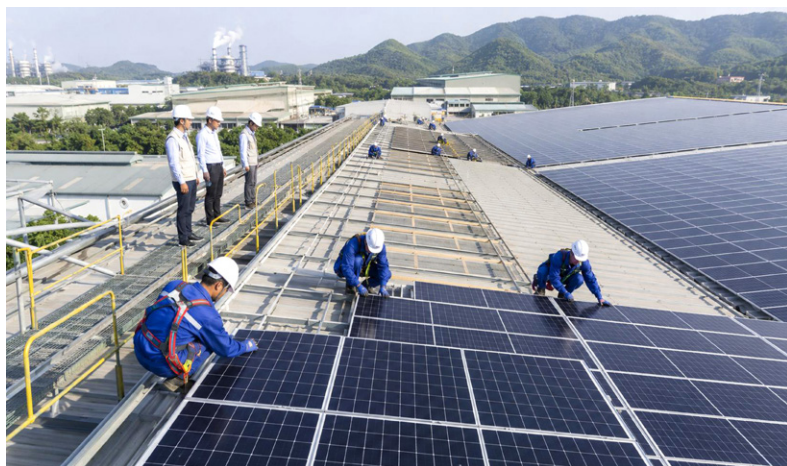
Nhiều tổ chức, doanh nghiệp trên địa bàn tỉnh Thái Nguyên chủ động lắp đặt hệ thống điện mặt trời mái nhà
